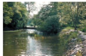
Le seuil du moulin de Viard
